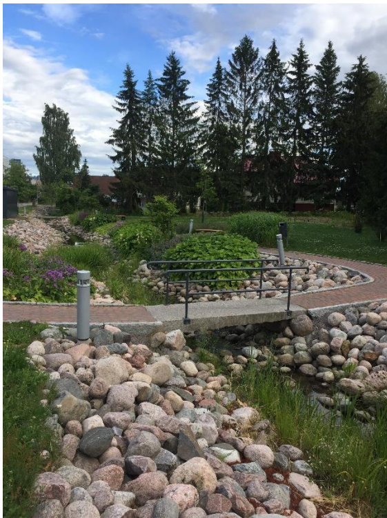
Hulevesipuisto Mäntsälässä. Kuva: Kati Vierikko
